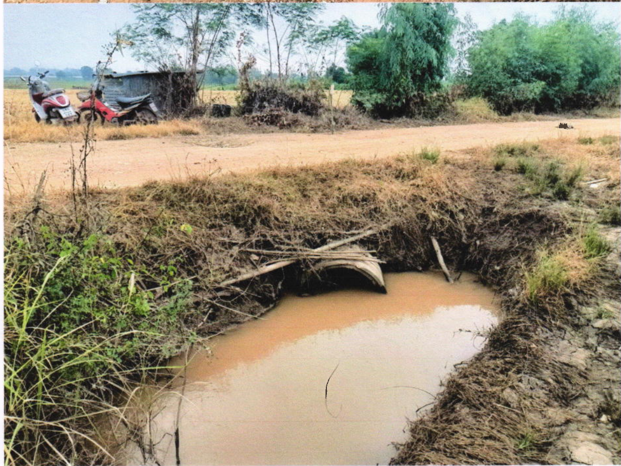
จุดที่ 2 ตรงทางแยกข้างมือซ้าย ทุ่งนา ทุ่งนา - ดมหญ้าที่ ๑ ไปดูหมอนที่ชาด บ้านหมอนที่ ๑
